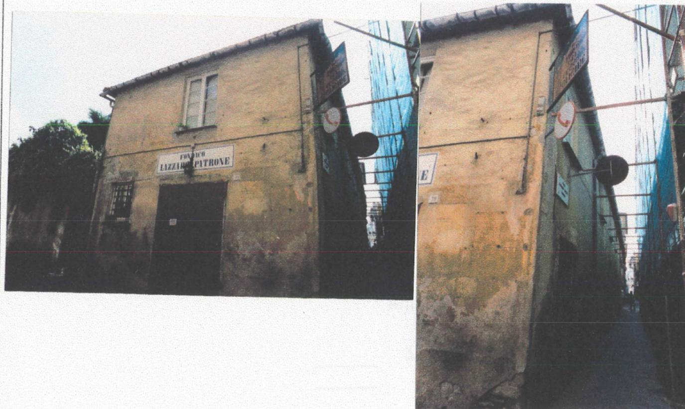
NOTE GENERALI: A QUESTO CNICO CORRISPONDE LA TRATTORIA DEL VECCHIO GLIAN CHE OCCUPA IL P.T. DELL' EDIFICIO E AMPIA PARTE DEL TERRENO SU' INTERNO DELL' ESEDRA. QUI SI TROVA DI TUTTO: DAUO SPAZIO PER I TAVOLI COPERTO CON STRUTTURA PRECARIA, ALLA CANTINA RICAUVATA IN UN PICCOLO CORPO IN MURATURA, AL W.C. RICAUVATO IN UN ALLARGAMENTO IN MURATURA DELL' EDIFICIO. NEL MURO IN PIETRA DELL' ESEDRA È STATO RICAUVATO UN ULTERIORE ACCESSO.
